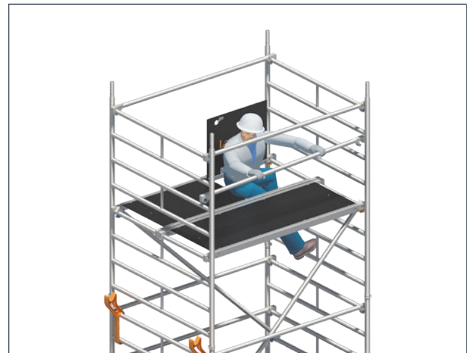
4. Montage der Zwischengeländer aus gesicherter Position im Bereich der Durchstiegsklappe.
